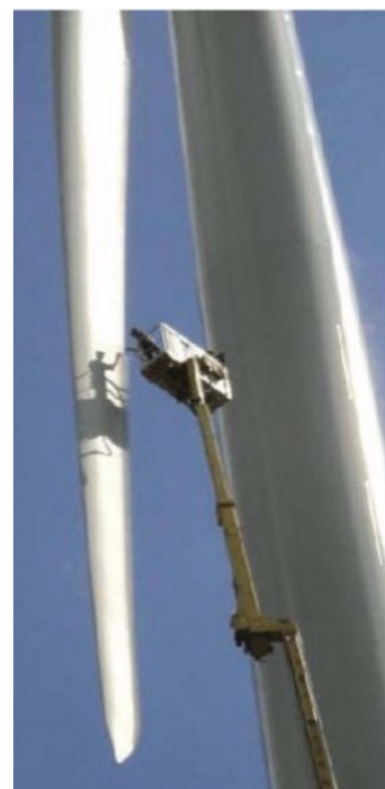
Figur 12 - "Hajtänder" skruvas på verk i Laholms kn för att akut lösa bullerproblem 72 .
