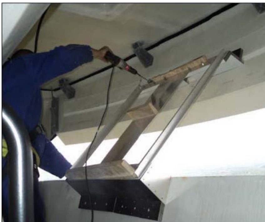
Figur 12 - "Hajtänder" skruvas på verk i Laholms kn för att akut lösa bullerproblem 72 .
