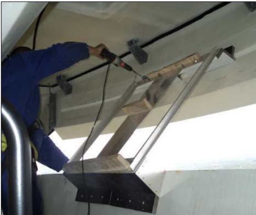
Figur 2 - "Hajtänder" skruvas på verk i Laholms kn för att akut lösa bullerproblem 61 .
