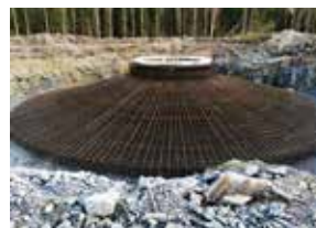
Varje verk kräver ett fundament av tusentals ton betong och armering.
